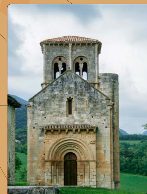
San Pedro de Tejada: Iglesia prioral; fachada occidental
