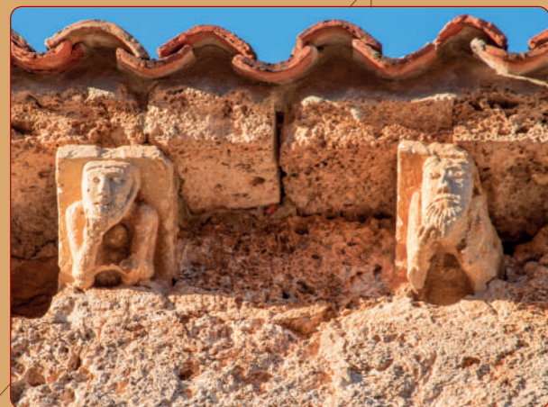
Ranera: Iglesia parroquial; canecillos del muro norte
