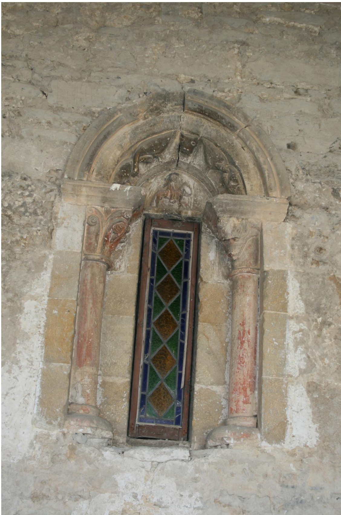
18.- Bercedo, iglesia parroquial; ventana del muro sur.
