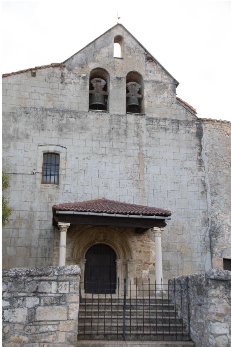
1.- Bocos, iglesia parroquial; fachada occidental.
