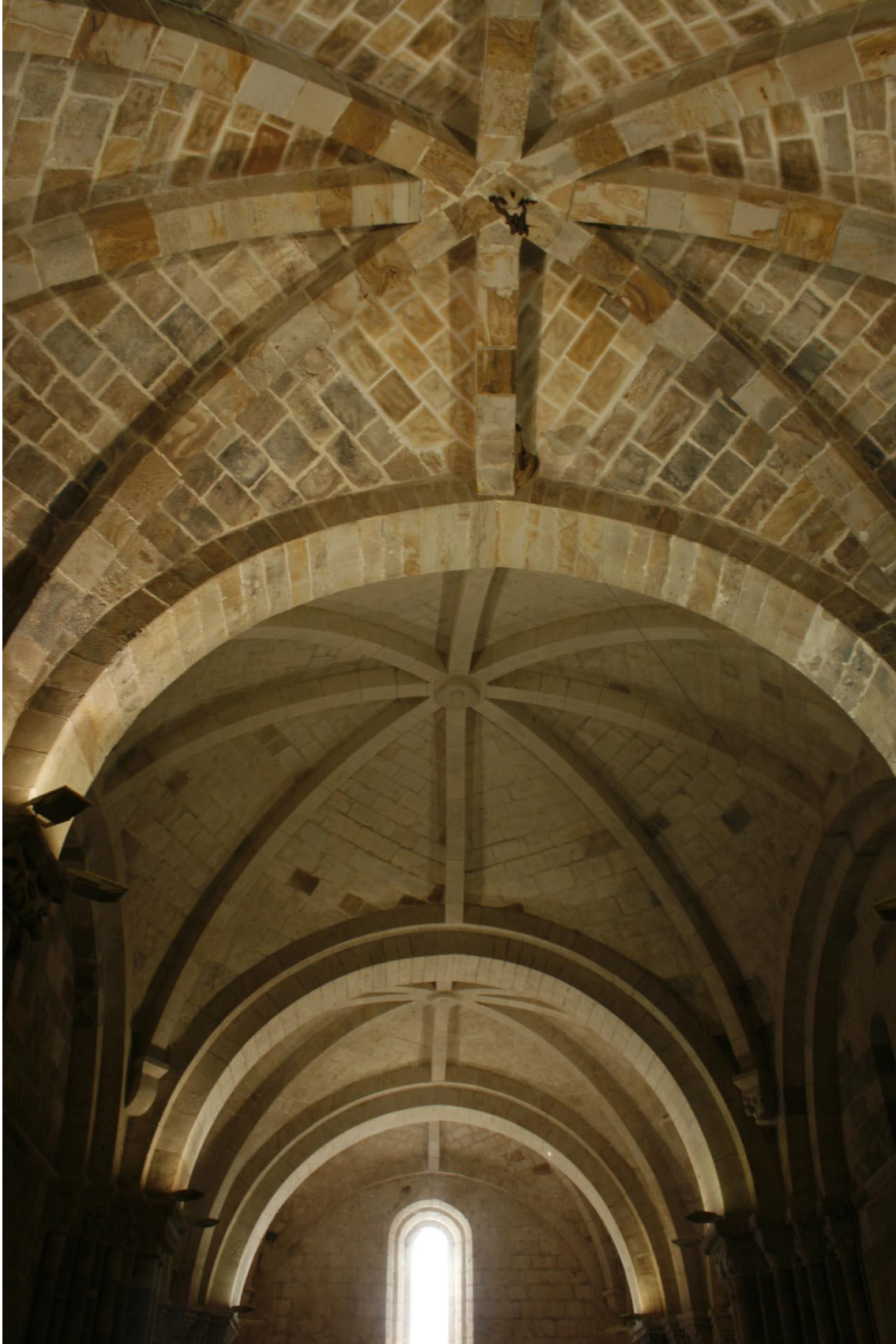
41.- Vallejo de Mena, iglesia parroquial; bóvedas de la nave vistas desde el ábside.
