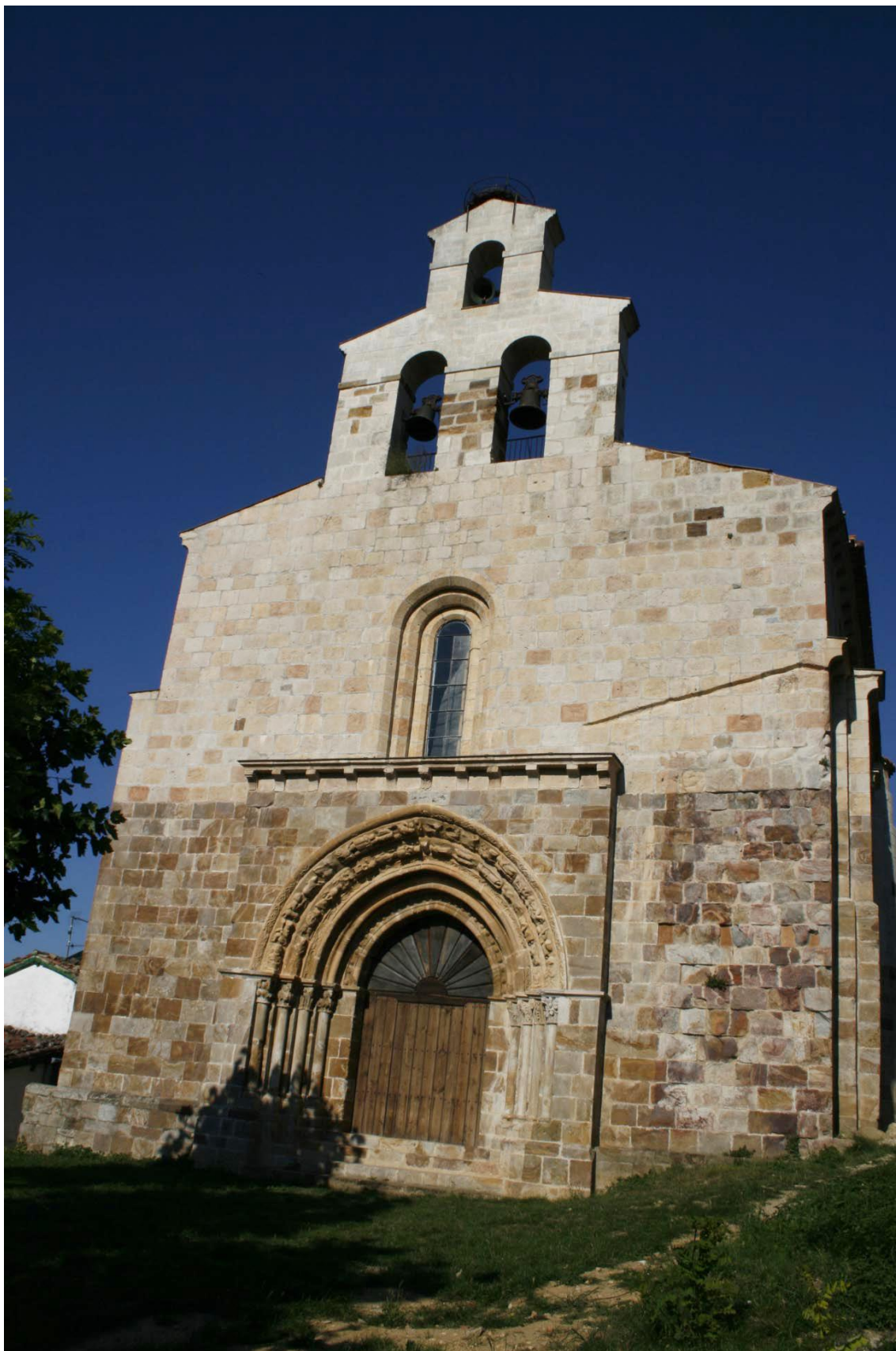
37.- Vallejo de Mena, iglesia parroquial; fachada occidental.
