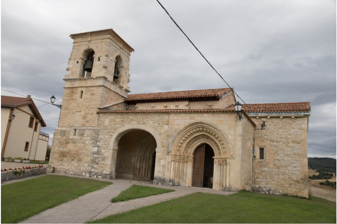
Uzquiano, iglesia parroquial; fachada meridional.
