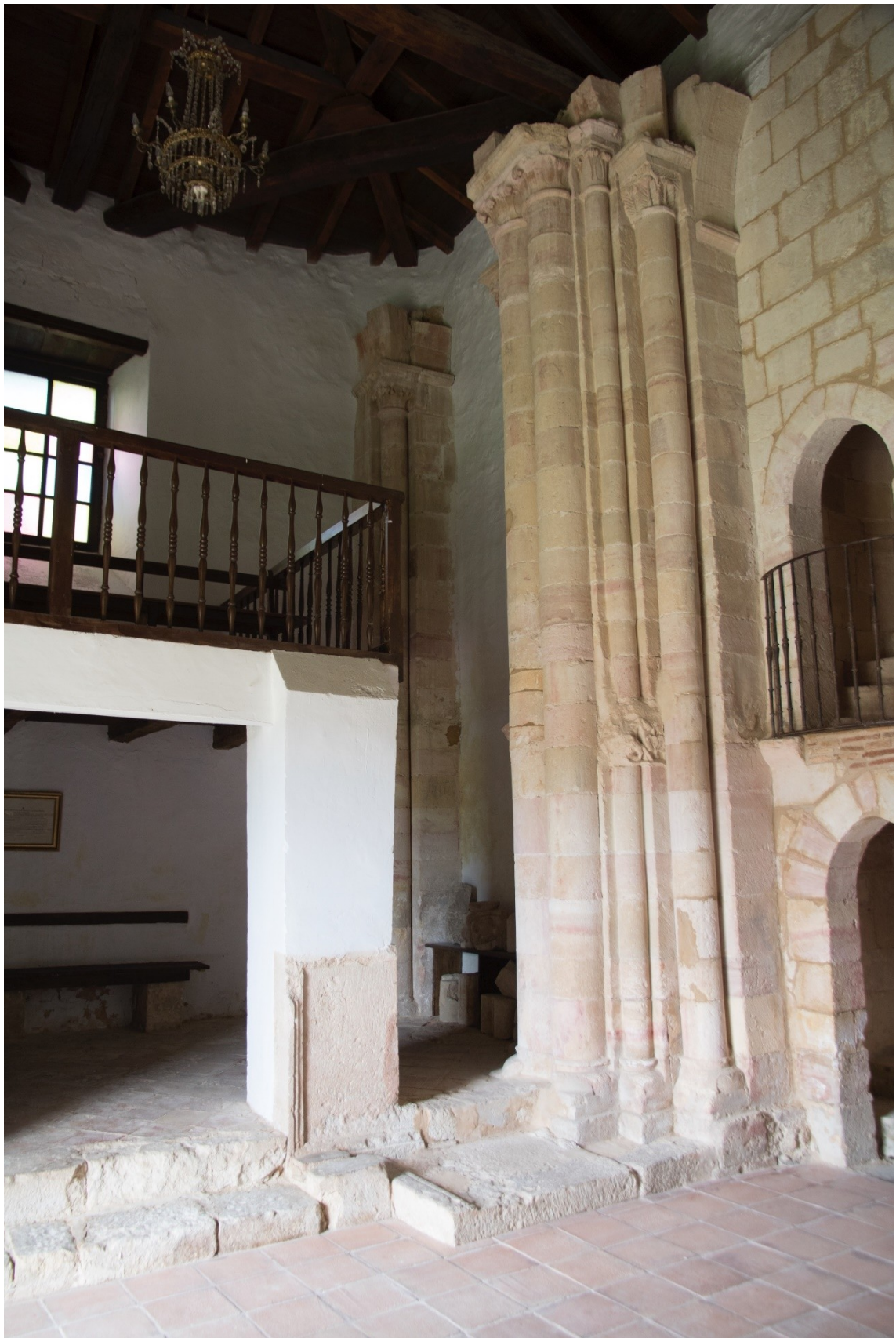
Treviño, ermita de San Juan; haz de columnas y pilar.
